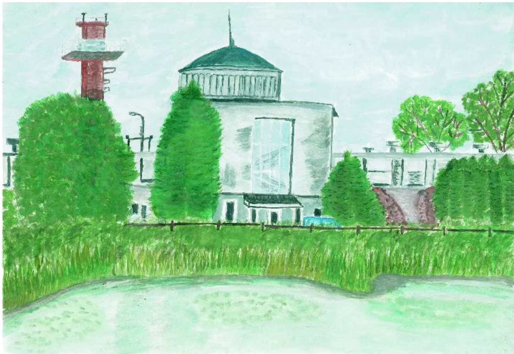
Elżbieta Naumowicz - Zakład Produkcji Wody w Ząbrowie (przed remontem)
